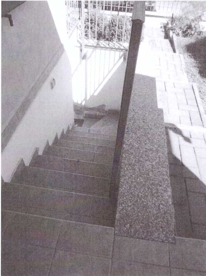
Foto 20: scala di accesso alla cantina
