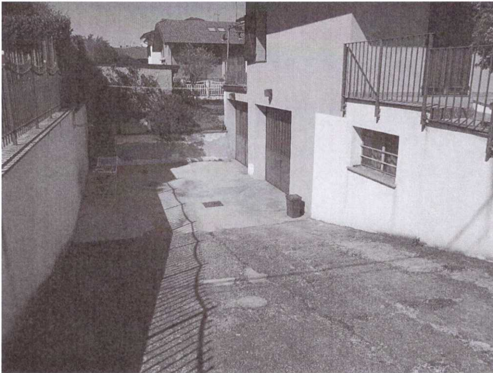
Foto 17: rampa box comune ad uso esclusivo
