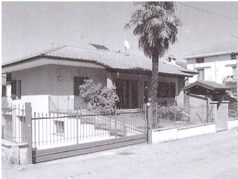
Foto 1: esterno via Asiago 3 Limbiate con ingresso pedonale e carroia
